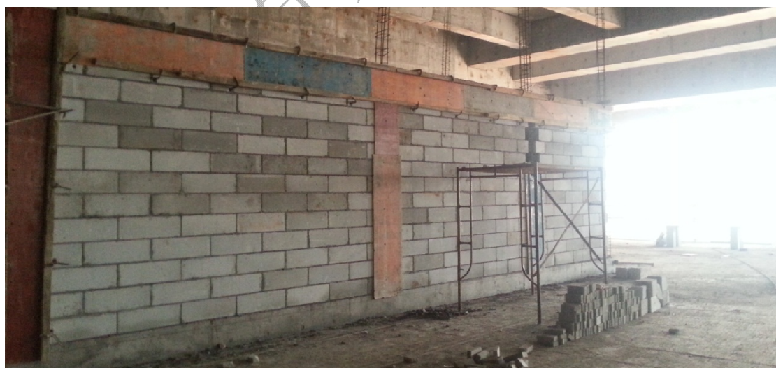
现场样板砌体
