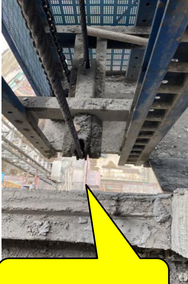
电梯口位置翻板缺失
